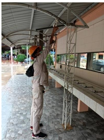
ภาพที่ 7 บุคลากรจากการไฟฟ้าส่วนภูมิภาคจังหวัดปราจีนบุรีตรวจสอบและแจ้งจุดเสี่ยงในโรงเรียน
